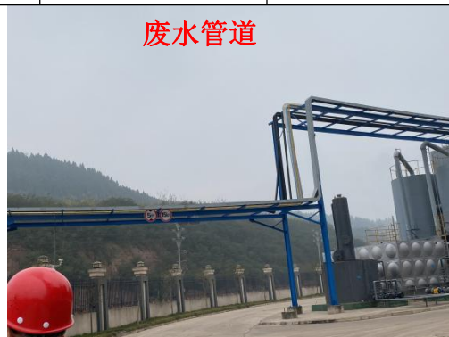
图 4-3 废水输送管道
